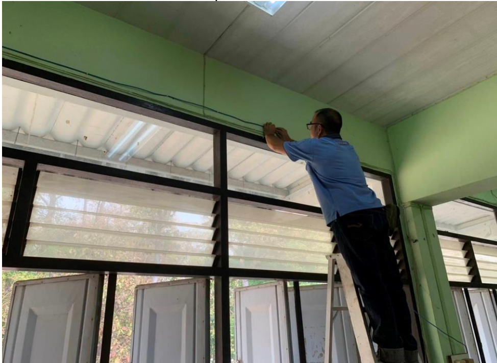
งานปรับปรุง ซ่อมแซมระบบไฟฟ้า
